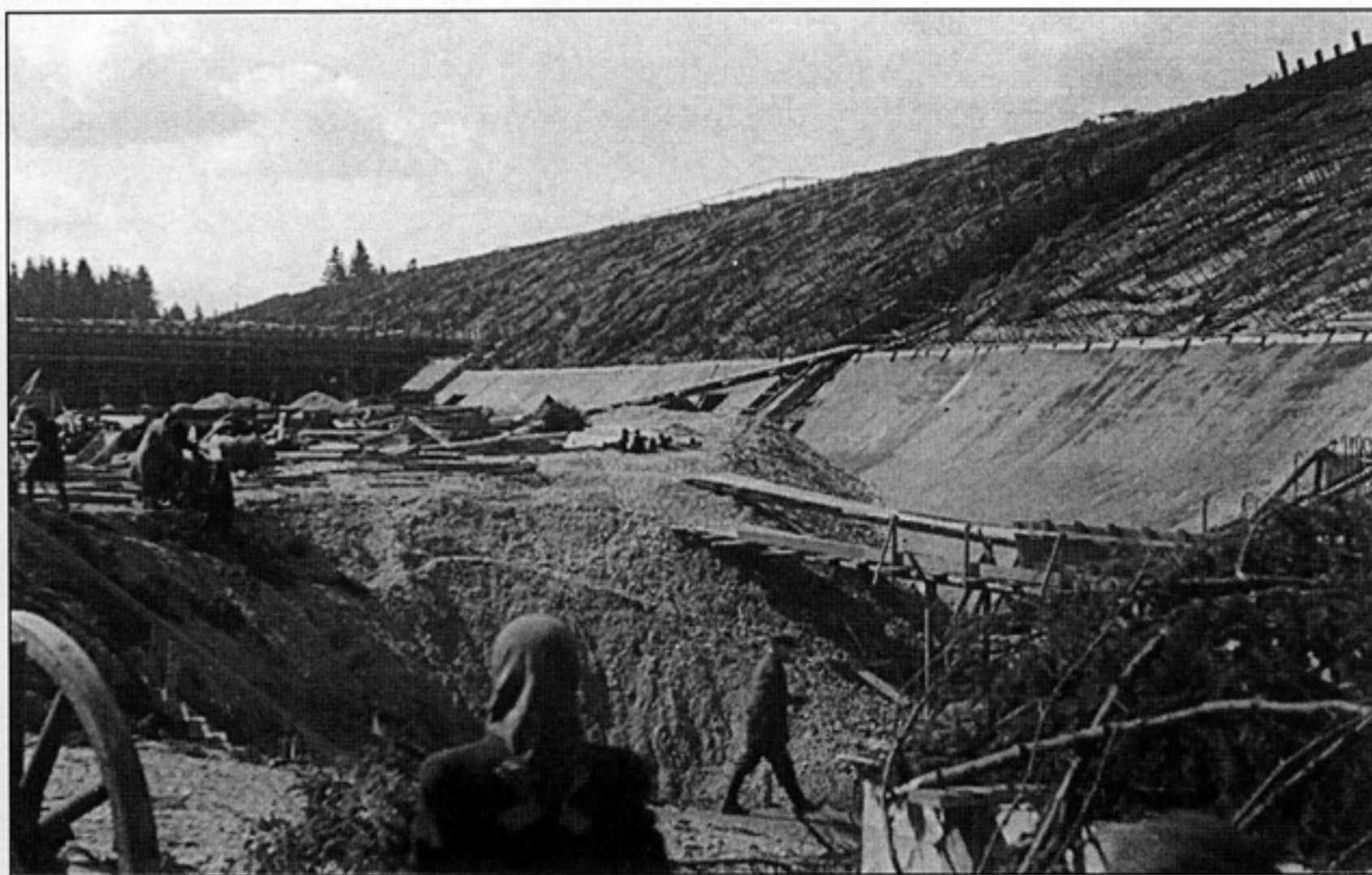
Frauenarbeit: Der Bunker wird mit Ästen und Zweigen getarnt.
